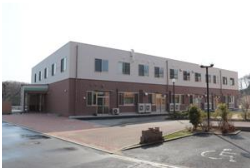
宇部フロンティア大学短期大学部 実験実習棟
